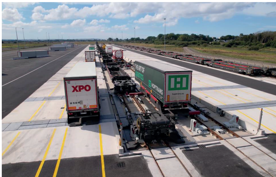
Rysunek 9. Terminal do załadunku naczep siodłowych systemem CargoBeamer
