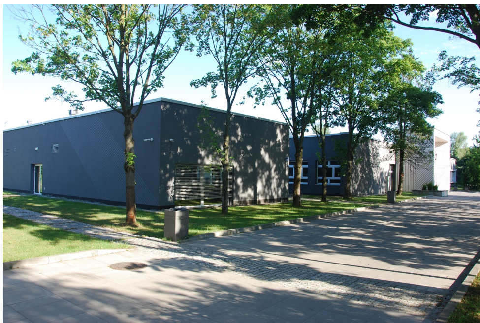
Rys. 17. Oddana do użytkowania rozbudowana część jednego z budynków Wydziału
