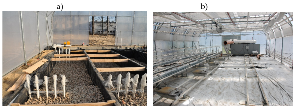
Rys. 20. Tunel z kamiennym akumulatorem ciepła: (a) akumulator na etapie budowy oraz widok akumulatora w tunelu (b)
