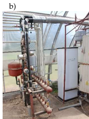
Rys. 25. System ogrzewania tunelu (a) wraz z węzłem cieplnym i kotłem sonicznym (b)
