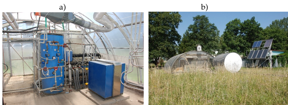
Rys. 19. Tunel foliowy wraz ze sprężarkową pompą ciepła w układzie monowalentym (a) oraz hybrydowym (b)
