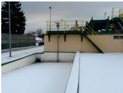
Rys. 6. Najazd dla samochodów podczas rozładunku za pomocą armatki wodnej
