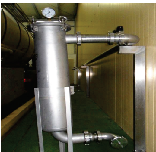
Rys. 2. Zbiorniki magazynowe wykonane ze stali nierdzewnej kwasoodpornej
