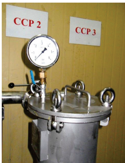
Rys. 1. Filtr bezpieczeństwa wraz z określonym punktem krytycznym systemu HACCP
