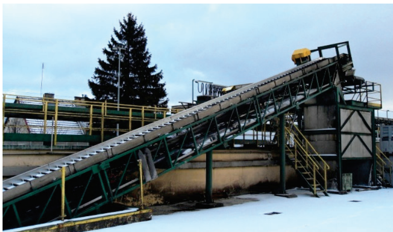
Rys. 8. Transport surowca podajnikiem taśmowym
