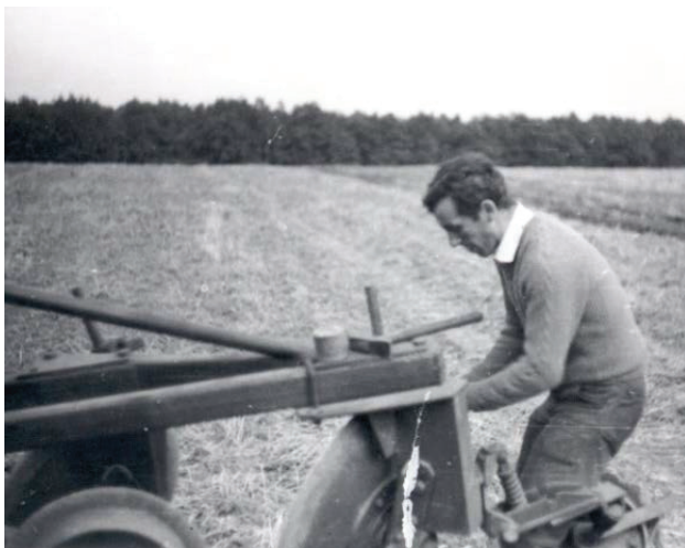
Regulacja głębokości orki wykonana w trakcie badań przez mgr inż. J. Kowalskiego
