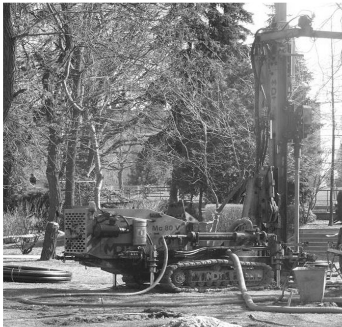
Rysunek 3.9. Wykonywanie odwiertów przeznaczonych na pionowe wymienniki gruntowe (Foto: R. Szulc)
