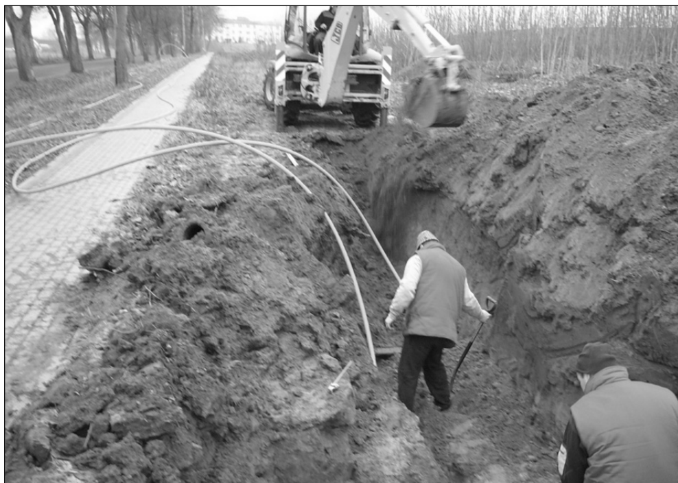
Rysunek 3.8. Sposób układania poziomego wymiennika gruntowego (Foto: A.Panas)
