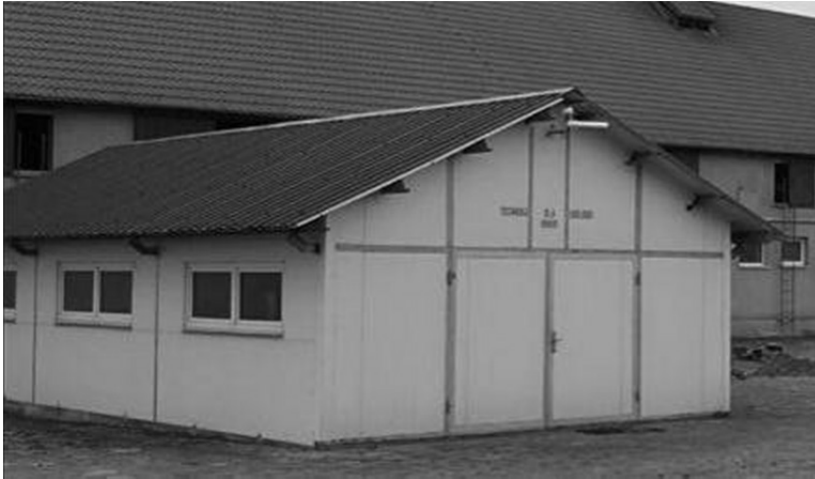
Rysunek 3.11. Pracownia energii odnawialnej z dachem w całości stanowiącym cieczowy płaski kolektor słoneczny (Foto: R. Szulc)
