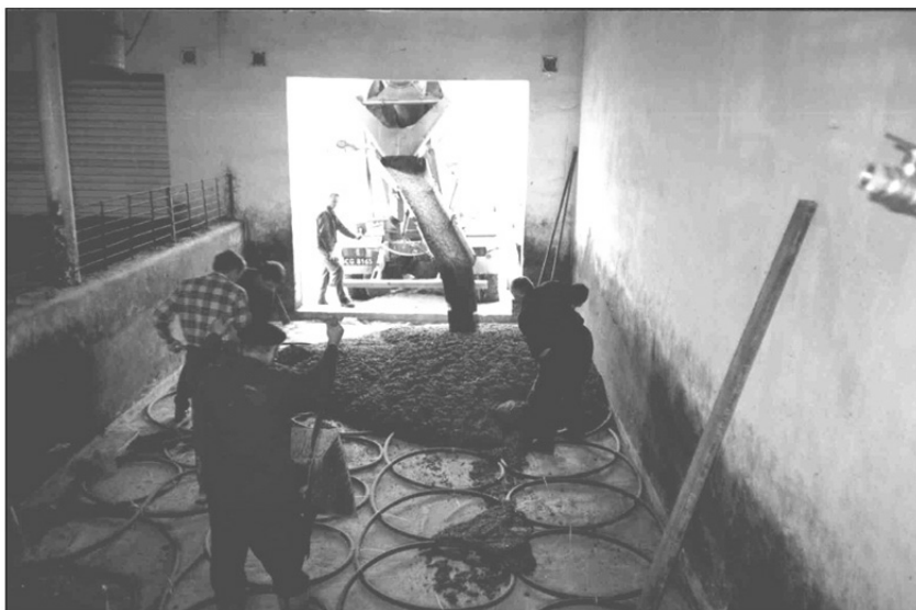
Rysunek 3.18. Moment zalewania posadzki w budynku inwentarskim z umieszczoną węzownicą
