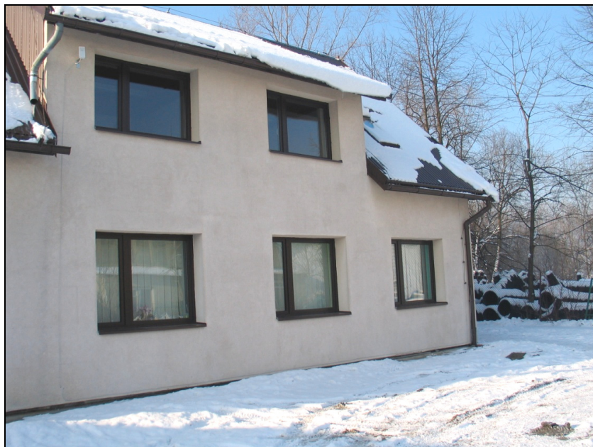
Fot. 49. Fragment budynku Górskiej Stacji Badawczej w Milówce
