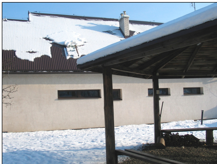
Fot. 50. Fragment zaplecza socjalnego i budynku Górskiej Stacji Badawczej w Milówce
