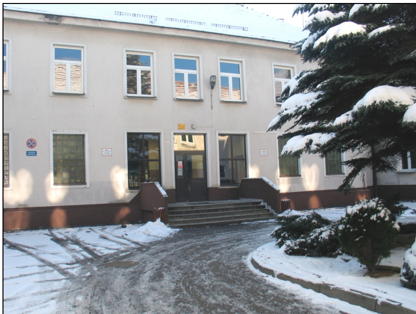
Fot. 58. Wejście tylne do szkoły w Żywcu-Moszczanicy
