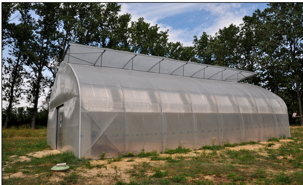
Fot. 7. Doświadczalny tunel foliowy do analizy zagadnień magazynowania nadwyżki ciepła
