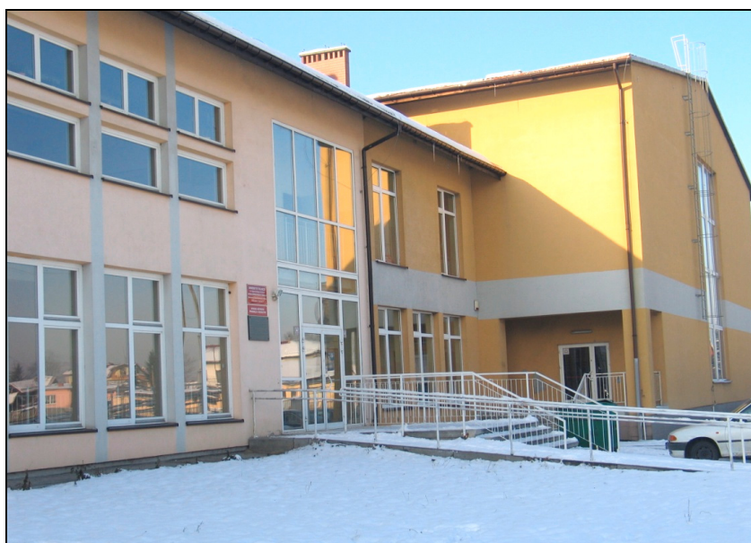
Fot. 56. Wejście do pomieszczeń ZOD w Milówce
